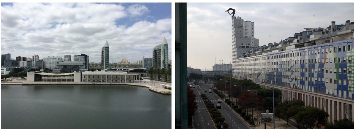
Fig 7: Recinto da EXPO-98, Lisboa e sentido de crescimento do Parque das Nações sentido Centro, 2011 (Fotos: J. Bassani)
